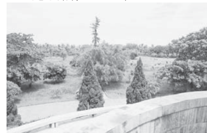
戦闘で破壊されたクワンチの城塞都市跡
